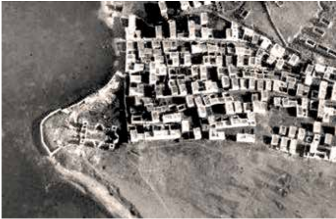
Τμήμα της συνοικίας του Αγ. Γεωργίου. Αριστερά διακρίνεται ο υπό ανέγερση ναός (αεροφωτογραφία 1920)
